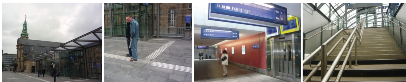
Foto: stazione ferroviaria. Alcune soluzioni per facilitare la mobilità per tutti: segnali tattili sul marciapiedi, ascensori per raggiungere ogni binario della stazione, doppio corrimano, segnali tattili e contrasti cromatici sui gradini. (© Isabella Tiziana Steffan, 2013)
