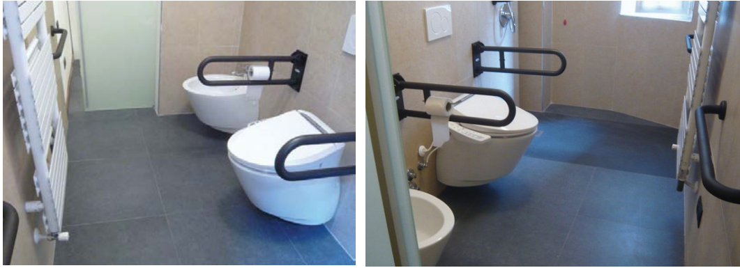
Foto: Il bagno dopo i lavori: la complanarità tra pavimento e piatto doccia, così come la continuità di materiali e colori, aumentano la percezione dello spazio utilizzabile (© Isabella Tiziana Steffan, 2012)
