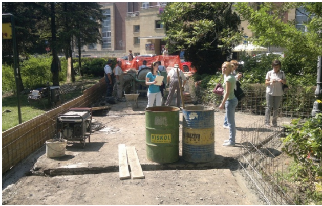
Foto: Lavori di ricostruzione all'ingresso del Parco del Danubio (© Rudić Počuĉ, 2012)
